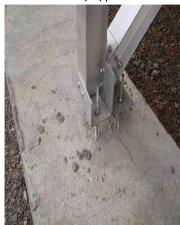
Φωτογραφία 17. Πέδιλο από σκυρόδεμα και τοποθέτηση βάσεων.
