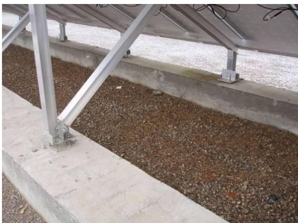
Φωτογραφία 16. Θεμελίωση Φωτοβολταϊκού Πάρκου.
