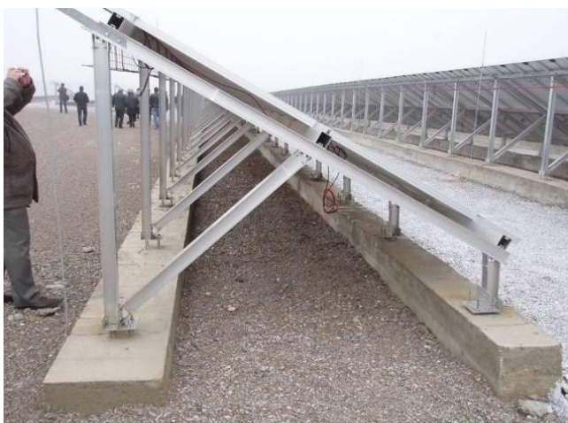
Φωτογραφία 18. Θεμελίωση Φωτοβολταϊκού Πάρκου.
